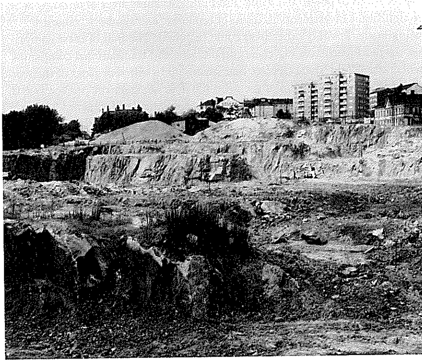
site Construction site in Kallio 23.7.1962. HCM
